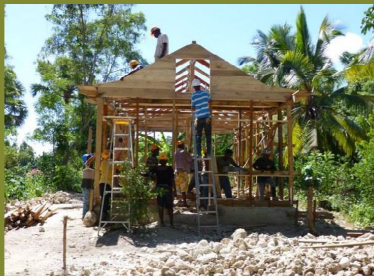
Images du chantier-école
